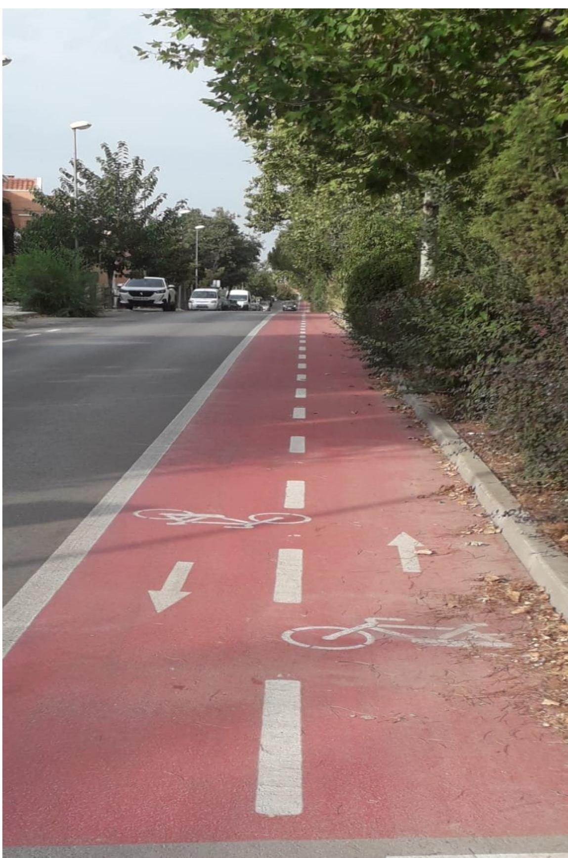
Modelo de plataforma bidireccional propuesta, con 2 carriles para ambos sentidos y una anchura de 2,5 metros. Foto tomada del tramo existente en la Avenida de la Ciudad de las Artes, de Aranjuez
